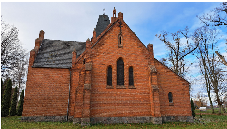
Fot. Elewacja wschodnia
