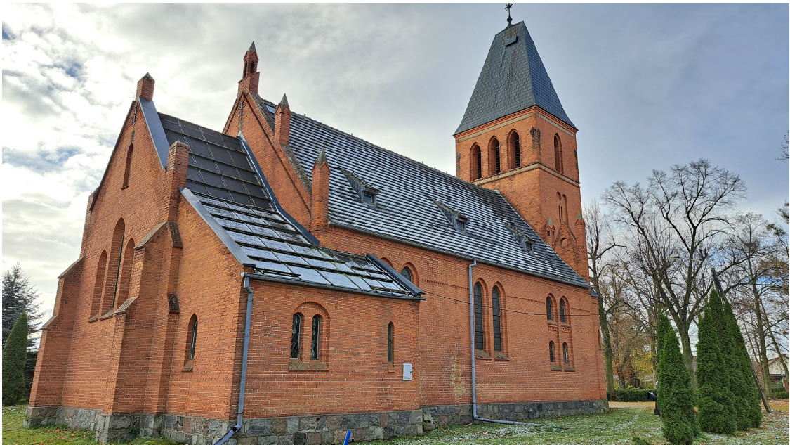
Fot. Elewacja północno-wschodnia
