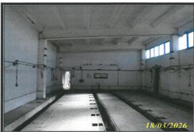
Widok głównej hali w perspektywie od strony zachodniego szczytu
